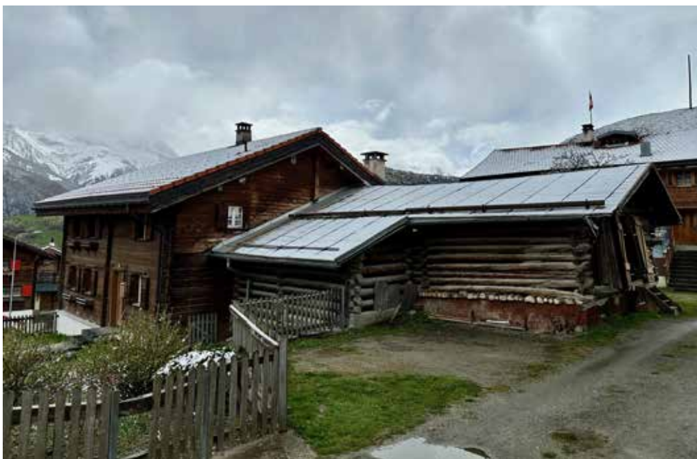
Casa pervenda Segnas cun clavau – ussa posseda la Pleiv igl entir clavau.
